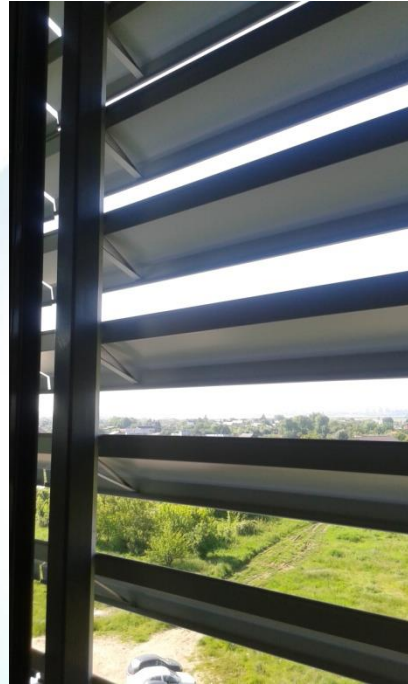
Sistemul de umbrire cu lamele metalice, imagine realizata din interiorul cladirii
