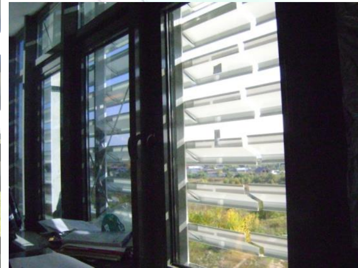
Sistemul de umbrire cu lamele metalice, imagine realizata din interiorul cladirii
