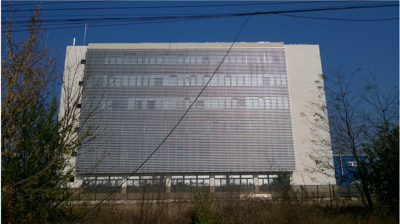
Cladirea INCD-ECOIND, imobil de birouri si laboratoare, vedere a fatadei sud
