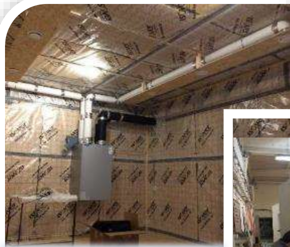
Ventilare Mecanică cu Recuperarea Căldurii
