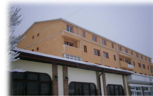
Bloc anvelopat termic, Dărmănești
